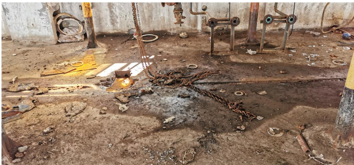
图 4.1-7 W 车间内情况
