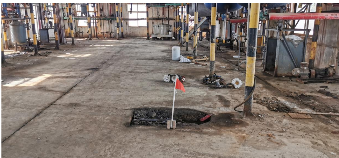
图 4.1-8 W 车间内情况
