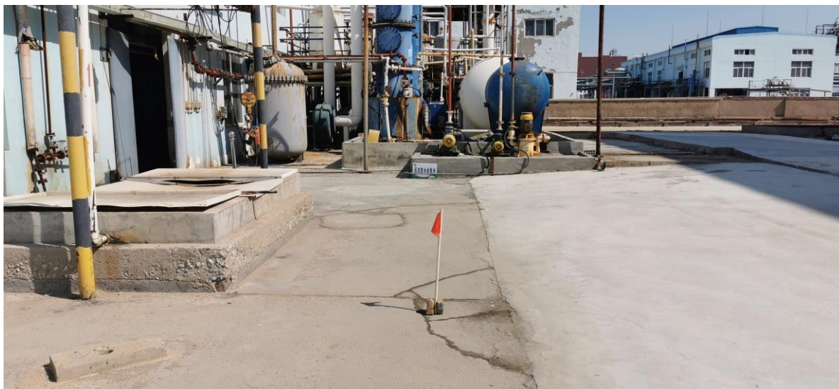
图 4.1-1 五车间南侧情况
