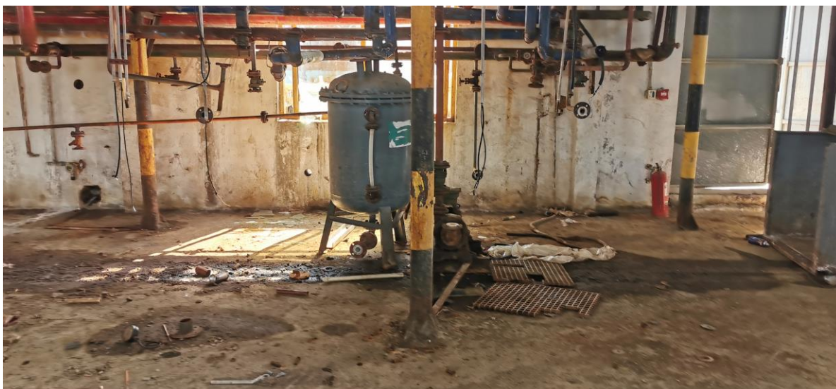
图 4.1-9 W 车间内情况
