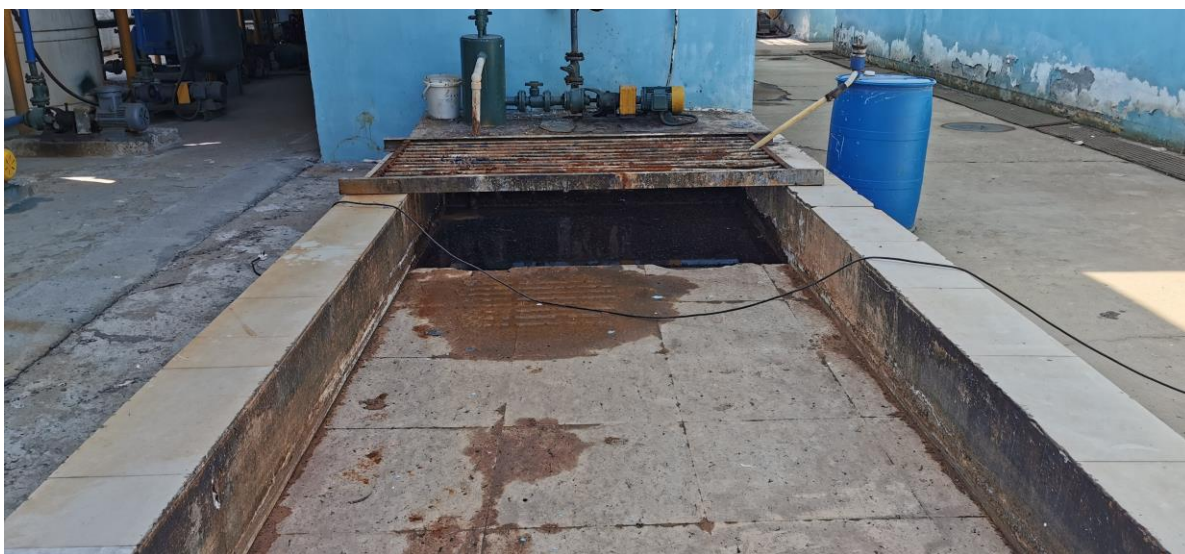
图 4.1-4 污水处理区域情况
