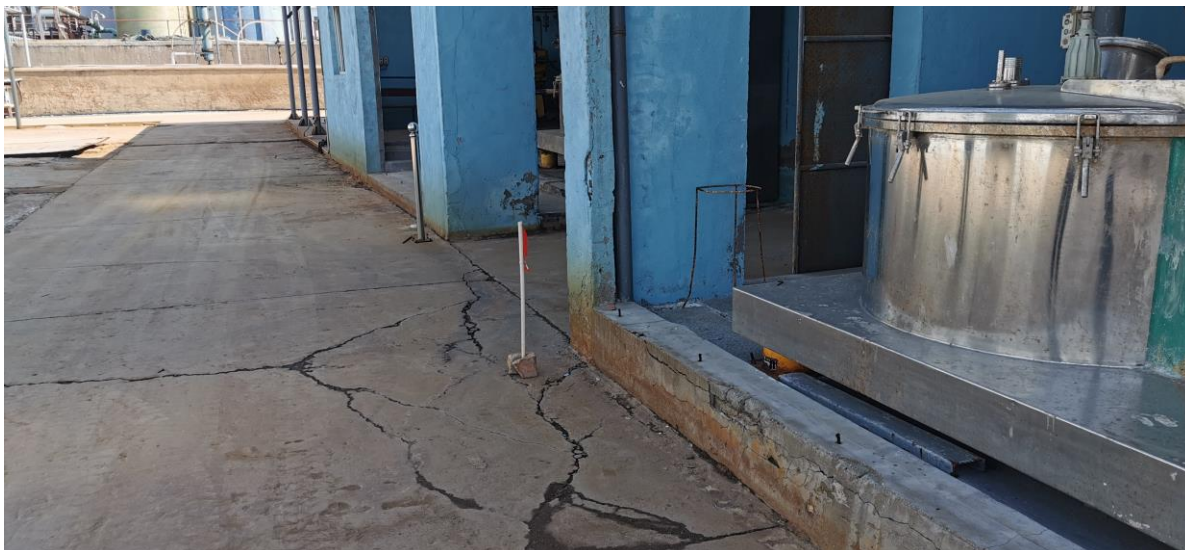
图 4.1-3 五车间北侧情况
