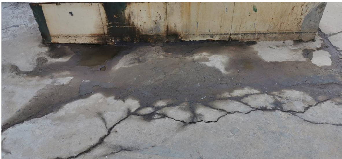
图 4.1-6 污水处理区域情况
