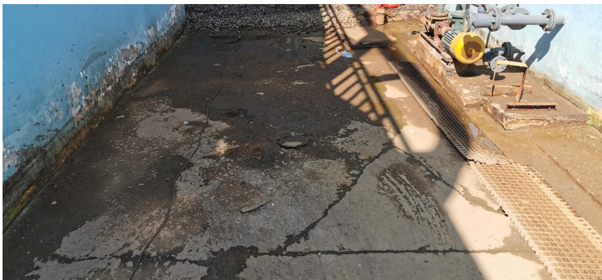
图 4.1-5 污水处理区域情况
